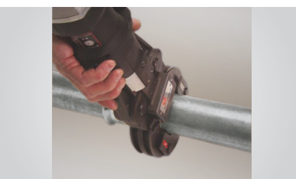
7. Verpressung abschließen
